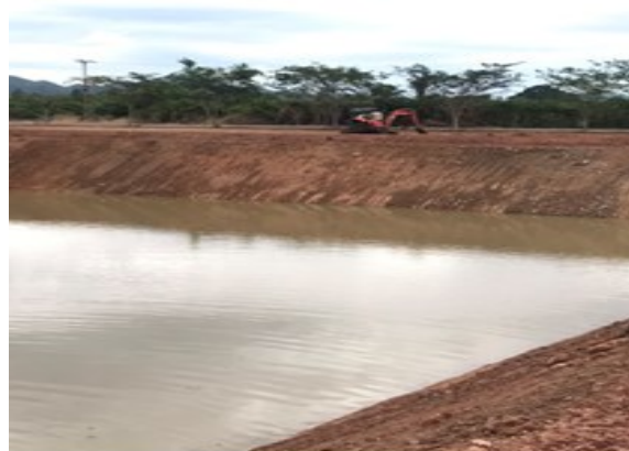
กิจกรรมพัฒนาแหล่งน้ำ โดยดำเนินการขุดสระน้ำและก่อสร้างฝาย
